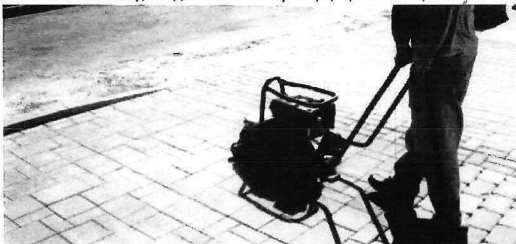
Zhutnenie dláždenej plochy pomocou vibračnej dosky s polyuretánovou podložkou
