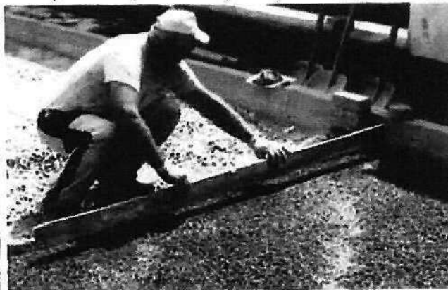
Vyrovnanie podkladovej vrstvy hliníkovou doskou
